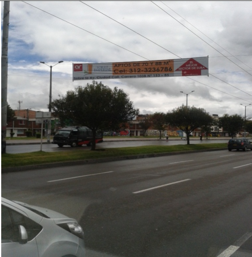
FOTO 4. ELEMENTOS INSTALADOS SOBRE POSTE EN LA CARRERA 104 CALLE 128
