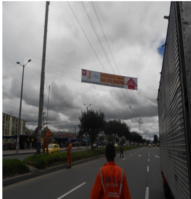
FOTO 3. ELEMENTOS INSTALADOS SOBRE POSTE EN LA CARRERA 104 CALLE 132
